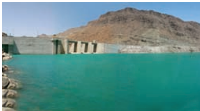
شکل ۱۹-۶- مهار آب های سطحی
