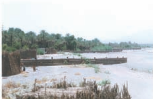
پی‌های احداث شده با هدف حفاظت کناره‌ها
