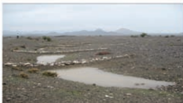
عملیات آبخیزداری احداث بندهای خشک‌چین شکل ۵۳-۱- مجموعه عملیات آبخیزداری
