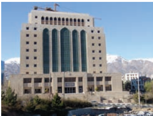
ساختمان گنجینه اسناد ملی
