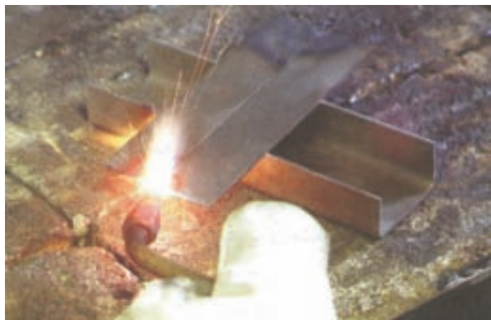
شکل ۸-۴۸-۱ خال جوش زدن در طرفین اتصال
