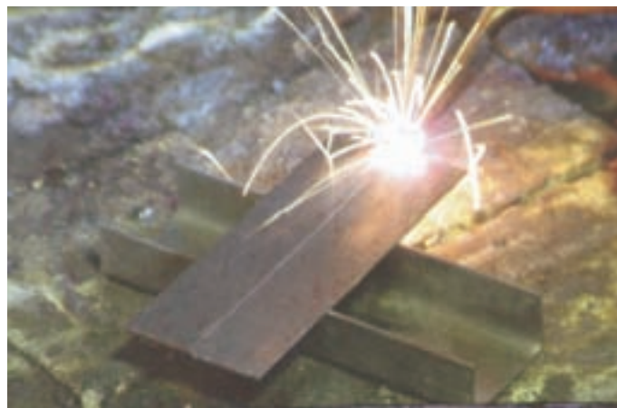
شکل ۸-۴۸ خال جوش زدن در طرفین اتصال
