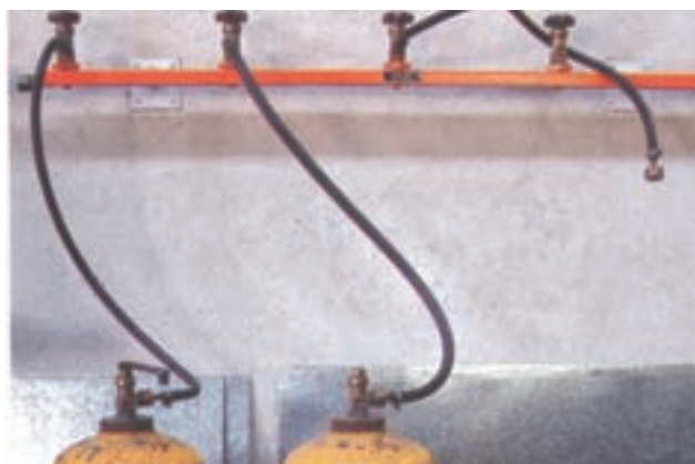
شکل ۱۹-۲ پست مرکزی استیلن
