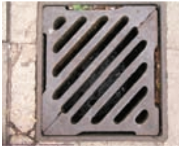
شکل ۲-۳ درب چاه‌های شهری از چدن
