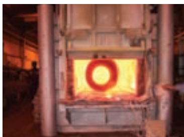
شکل ۲-۴۷: کوره عملیات حرارتی کارگاهی
