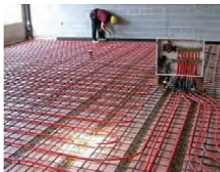
شکل ۱۴- سیستم گرمایش از کف
