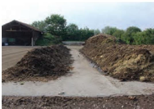
شکل ۲۲- شیبدار بودن کف کمپوست سازی (راست)، مسقف بودن محل کمپوست سازی (چپ)
