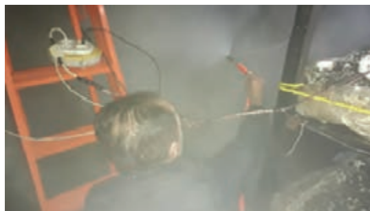
شکل ۱۷- مرطوب کردن کف و دیوارها با آب گرم و بخار آب
