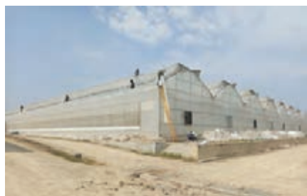
شکل ۸- گلخانه با سقف گنبدی
