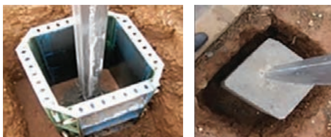
شکل ۱۲- فونداسیون سازه گلخانه
