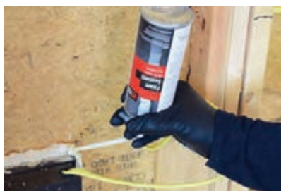
شکل ۱۹- دیوار عایق شده (راست) و پوشش‌دهی درزها و منافذ سالن (چپ)
