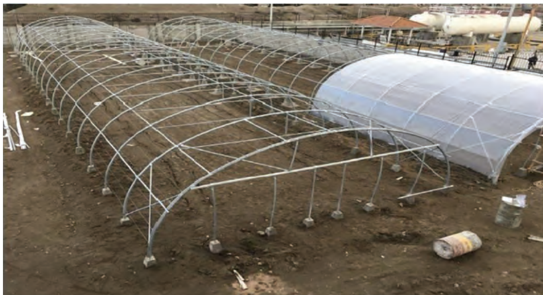
شکل ۲۱- اجرای عملیات سیم کشی هم‌زمان با نصب پوشش پلاستیک در گلخانه کوچک مقیاس
