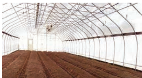
شکل ۲- عملیات آماده سازی زمین گلخانه (بالا) و آماده سازی پشته های کشت (پایین)
