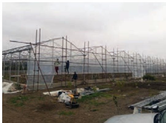
شکل ۱۹- نصب پوشش پلی اتیلن روی سازه گلخانه
