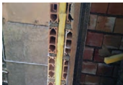
شکل ۱۹- دیوار عایق شده (راست) و پوشش‌دهی درزها و منافذ سالن (چپ)
