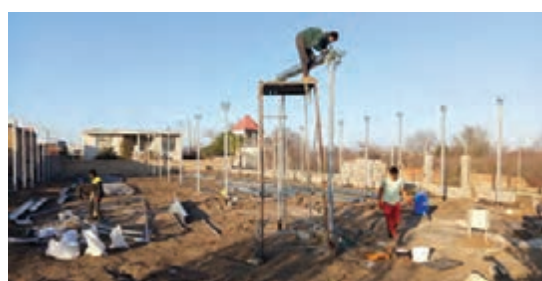
شکل ۱۶- نحوه نصب اجزای سازه گلخانه
