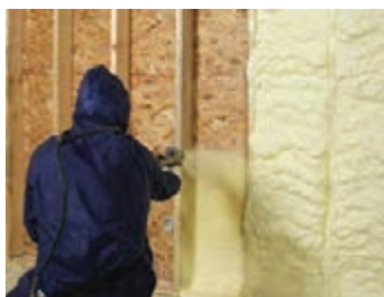
شکل ۱۸- عایق‌بندی سالن با استفاده از پلاستیک (راست)، فوم (وسط) و ساندویچ پنل (چپ)
