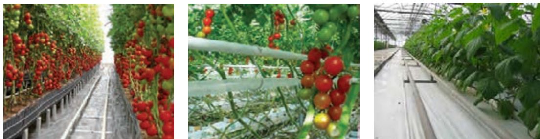
شکل ۲۳- استفاده از لوله‌های آب گرم در گرمایش گلخانه
