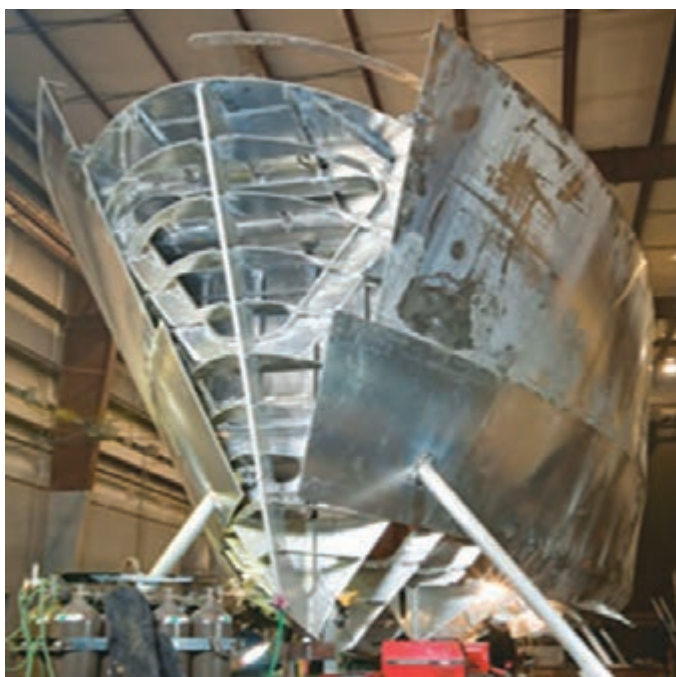
شکل ۲۳- سازه سینه یک شناور در حال ساخت
