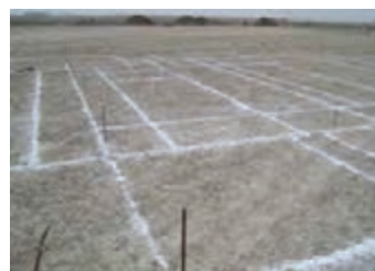
زمین گچ‌ریزی شده
