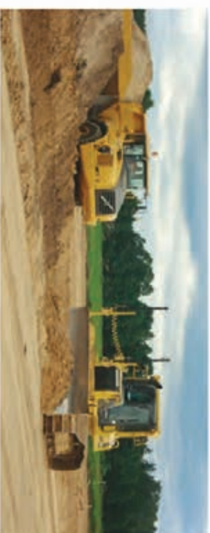
بلدوزر و کامیون در حال تسطیح محوطه
