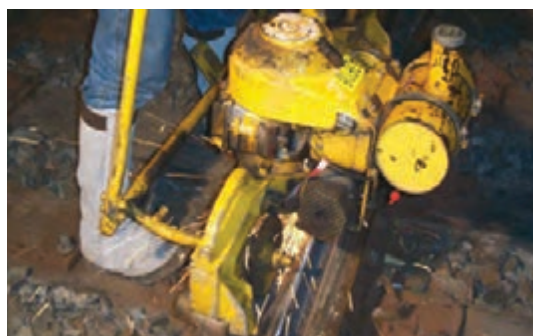
شکل ۲۵- سنگ زنی و پرداخت کاری سطح گرده
