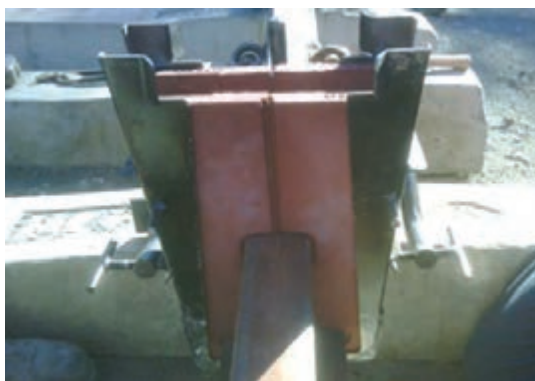
شکل ۱۸- نصب قالب اطراف ناحیه اتصال
