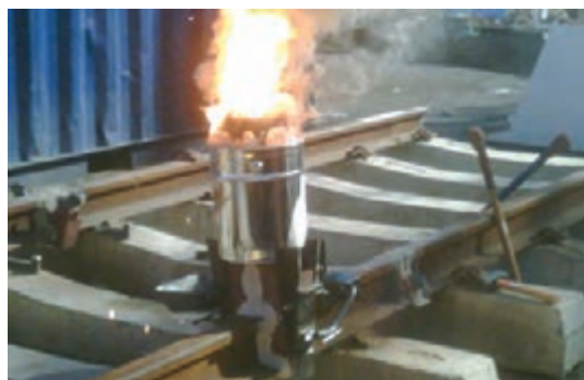
شکل ۲۱- نمایی از انجام واکنش ترمیت
