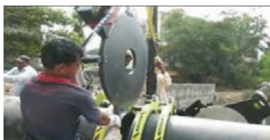
شکل ۱۸- جوشکاری لب به لب Butt Fusion
