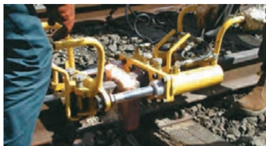
شکل ۲۴- برش گرده اضافی جوش
