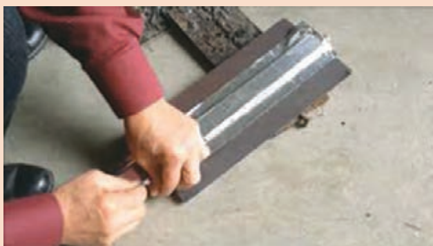
شکل ۱۸- نصب پشت بند سرامیکی
