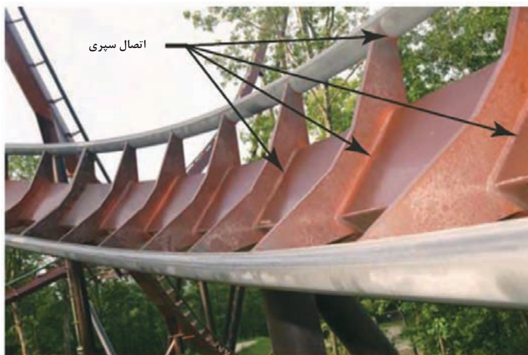
شکل ۱۲- کاربرد اتصال سپری
