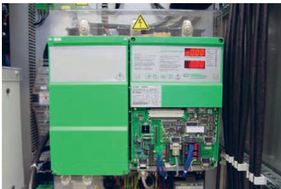
شکل ۴۵- یک درایور برای راه‌اندازی و کنترل موتور اصلی دستگاه چاپ
