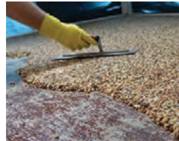
شکل ۳-۴۳- نمایش نحوه پخش و اجرای اپوکسی گرانیته
