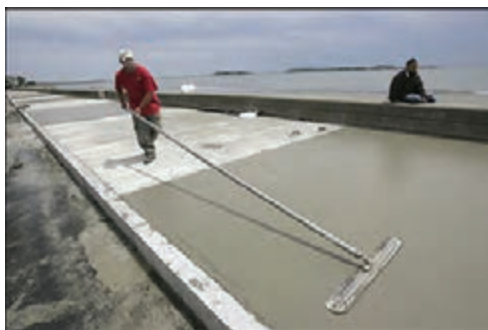
❖ شکل ۳-۵۵ رویه نهایی معابر با بتن درجا
