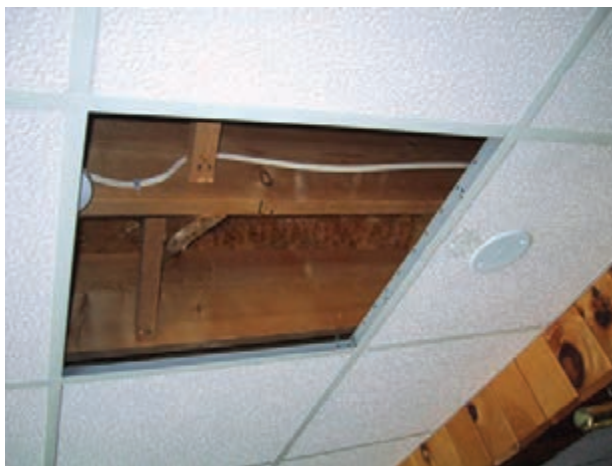
► شکل ۱-۶۲ سقف کاذب تایل گچی با شبکه فلزی
