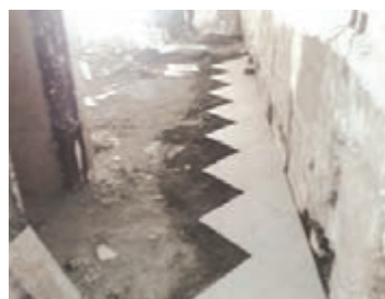
شکل ۱۹-۱ الف جزئیات کف سازی در فضاهای داخلی
