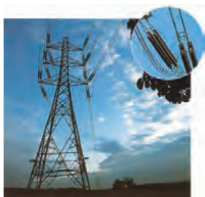
شکل ۳-۳۰- سیم‌های رابط خطوط انتقال باید دارای مقاومت کمی باشند. مقاومت این سیم‌ها از نوع مقاومت‌های مزاحم است.
