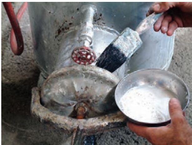
شکل ۲-۳۹- کنترل نشتی گاز
