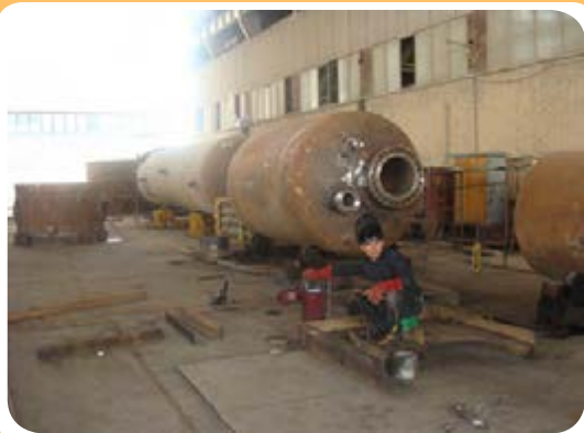
ب) کارگاه ساخت مخازن تحت فشار
