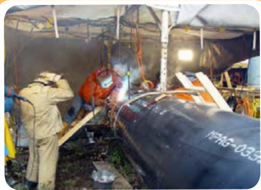
ن) کارگاه ساخت خط لوله
