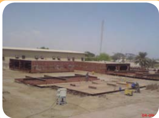
د) کارگاه ساخت اسکلت فلزی ساختمان
