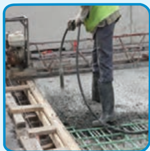
شکل ۱۴-۳- ویراتور یا لرزاننده بتن داخل قالب
