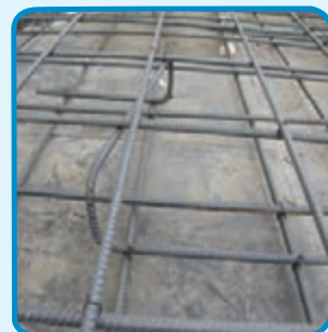
شکل ۳-۵۵- استفاده از خرک در میلگرد گذاری دال
