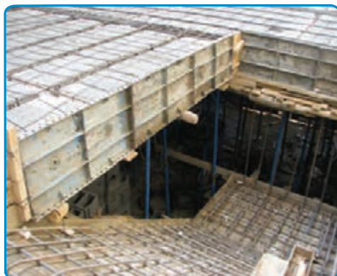
شکل ۷-۴۰- اجرای میلگردهای دال پله
