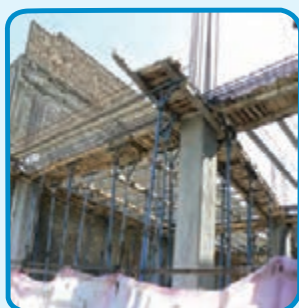
شکل ۳-۳۹- استفاده از قالب چوبی برای اجرای تیر
