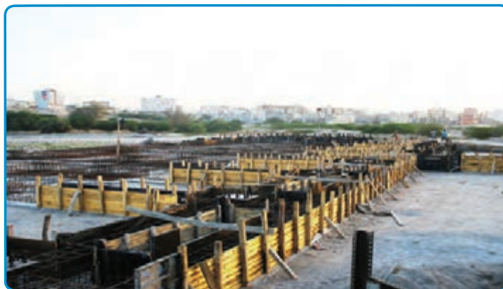
شکل ۳-۲۷- قالب چوبی برای اجرای پی
