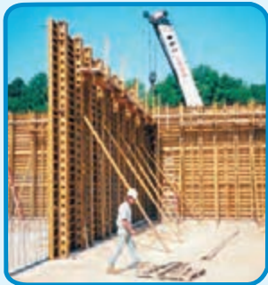
شکل ۱۹-۳- فایبر گلاس برای اجرای دیوار بتنی
