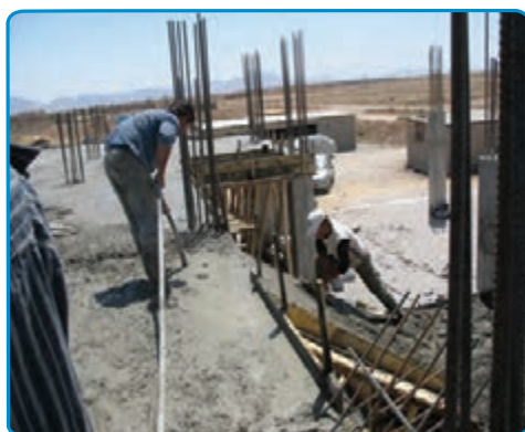
شکل ۷-۴۲- بتن ریزی دال پله
