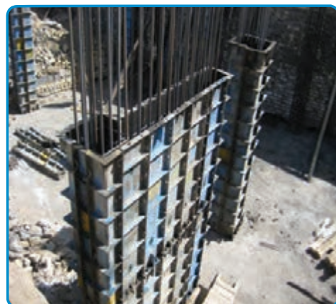
شکل ۳-۳۵- قالب فلزی برای اجرای دیوار بتنی
