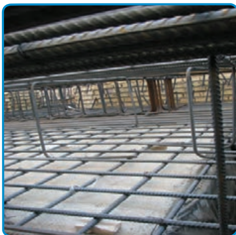
شکل ۳-۵۳- استفاده از خرک در میلگرد گذاری پی
