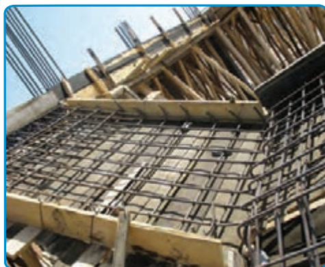
شکل ۷-۳۸- اجرای میلگردهای دال پله
