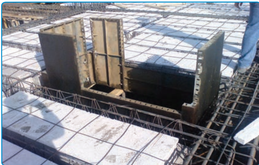
شکل ۳۵-۷- تکمیل قالب بندی
