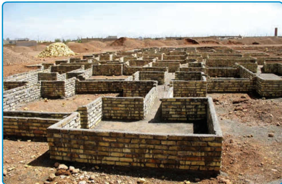
شکل ۱۵-۳- استفاده از قالب آجری برای اجرای پی
