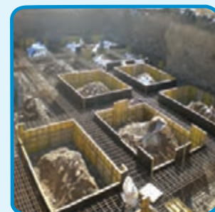
شکل ۳-۳۱- قالب فایبرگلاس برای اجرای پی
