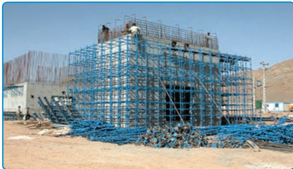
شکل ۳-۲۶- داربست فلزی
