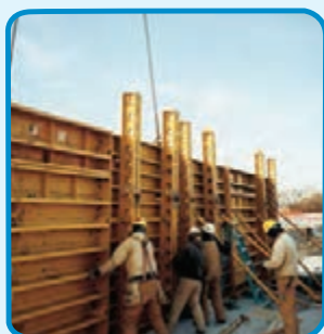
شکل ۳-۳۶- قالب فایبر گلاس برای اجرای دیوار بتنی
