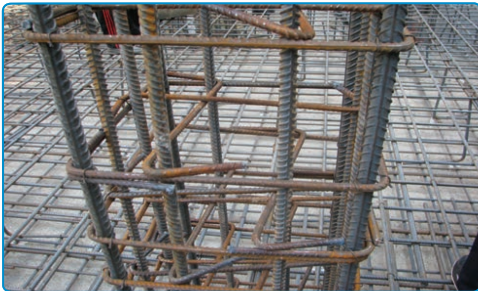
شکل ۵۰-۳- کاربرد سنجاقک در میلگرد گذاری ستون
