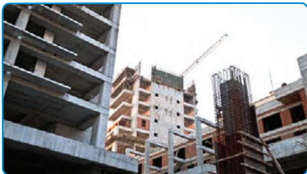
شکل ۱-۲- سازه‌های بتن آرمه
