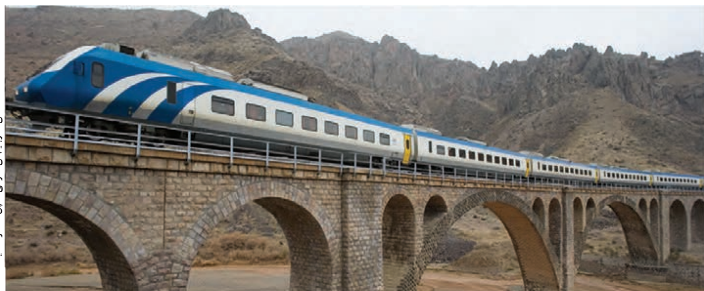
استان آذربایجان شرقی - پل دختر - میانه
