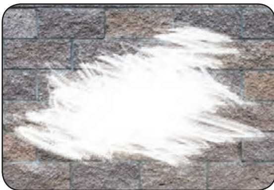
گچ روی دیوار
