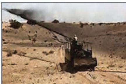
شکل ۱۴- پاشیدن مالچ نفتی برای جلوگیری از حرکت خاک
