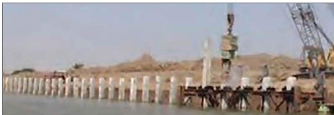
شکل ۱۱- شمع کوبی کنار سواحل از برخورد شدید آب با خاک کنار ساحل جلوگیری می‌کند.
