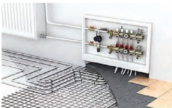
شکل ۶- نصب دستگاه کاهش دما
