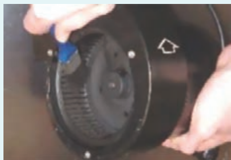
تمیز کردن فن مشعل از گردوغبار
