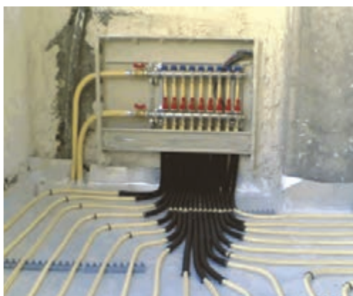
شکل ۴۱- عایق کاری لوله‌های زیر جعبه
