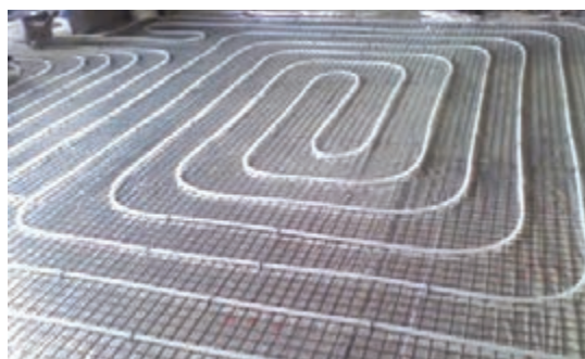
شکل ۱۶- مش فلزی و نحوه اجرا
