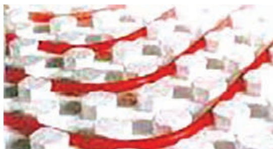
شکل ۱۸- لوله روی عایق زائده دار
