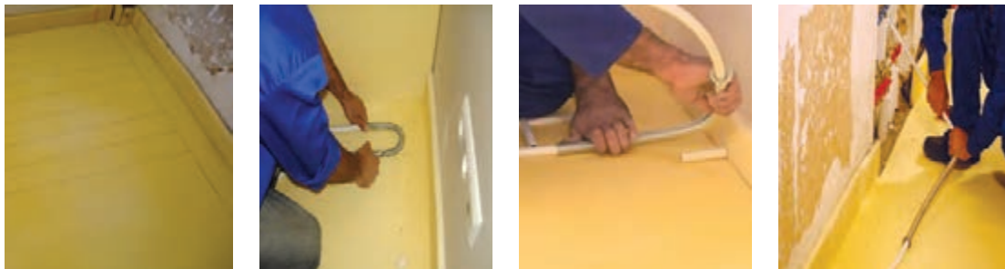
شکل ۳۷- استفاده از فنر برای خم کردن لوله
