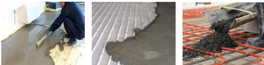
شکل ۵۷ - پوشش لوله‌ها با ملات سیمان
