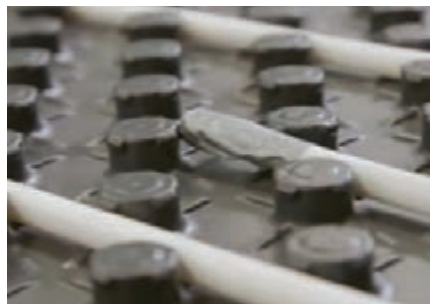
شکل ۵۱- محل نصب سنسور کف
