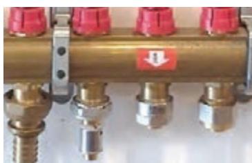
شکل ۳۹- متصل نمودن مولتی فیت به لوله و کلکتور
