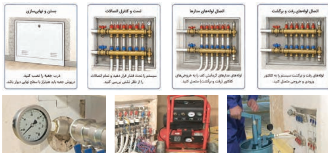
شکل ۴۹- تست لوله‌کشی
