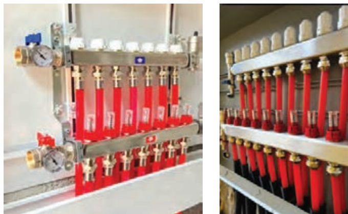
شکل ۳۸- اتصال لوله کشی به کلکتور
