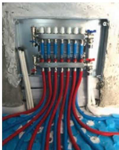
شکل ۴۲- به کارگیری عایق خرطومی
