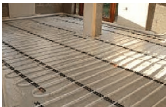
شکل ۴۴- ثابت کردن لوله با بست ریلی
