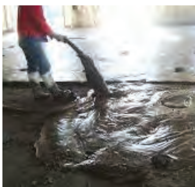
شکل ۹- کف سازی ساختمان با فوم بتن
