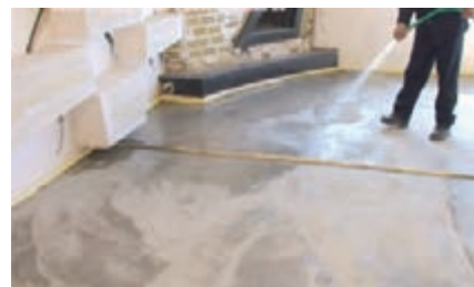
شکل ۵۸ - پاشیدن آب روی بتن
