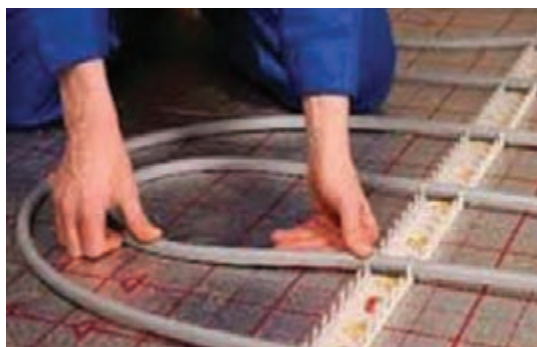
شکل ۴۴- ثابت کردن لوله با بست ریلی
