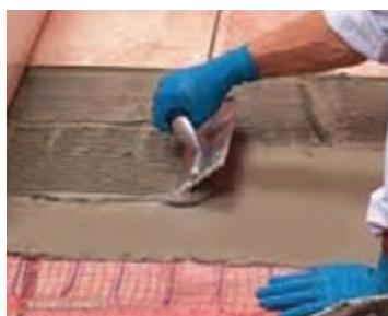
شکل ۶۰- پوشش لوله‌ها با ملات سیمان
