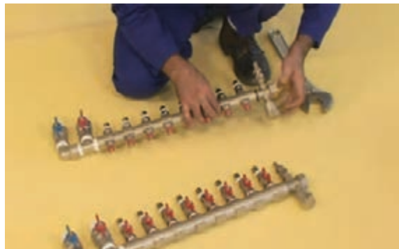
شکل ۳۲- مونتاژ کلکتور
