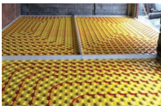
شکل ۴۵- اجرای درز انبساطی و نصب غلاف
