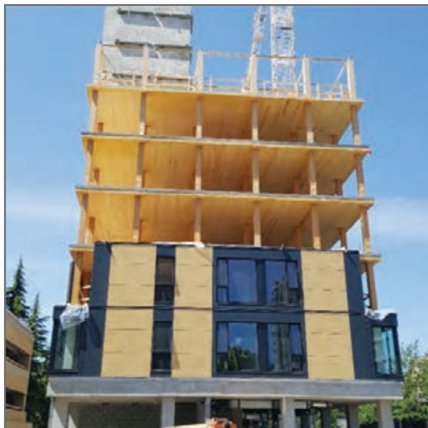
شکل ۱۸- ساختمان چندطبقه با CLT
