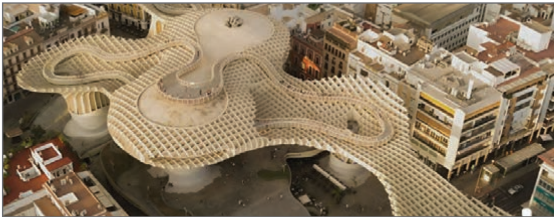
شکل ۱۵- سازه متروپل پارسول در اسپانیا
