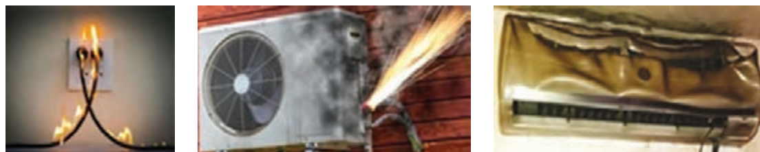
شکل ۵۷- آسیب به تجهیزات الکتریکی
