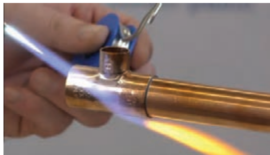
شکل ۴- کاربرد قلع (لحیم کاری)
