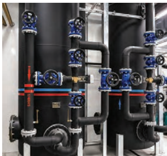
شکل ۵ - کاربرد EPDM روی دستگاه‌ها و لوله‌کشی
