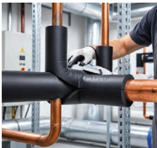
شکل ۵ - کاربرد EPDM روی دستگاه‌ها و لوله‌کشی
