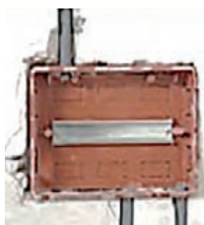
ب) نصب تابلو توزیع
