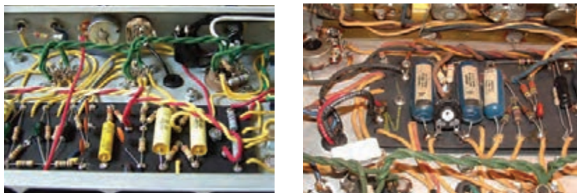
شکل ۱- نصب قطعات الکترونیکی در دستگاه‌های قدیمی
