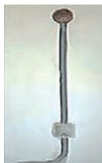
ج) نصب لوله و قوطی کلید
