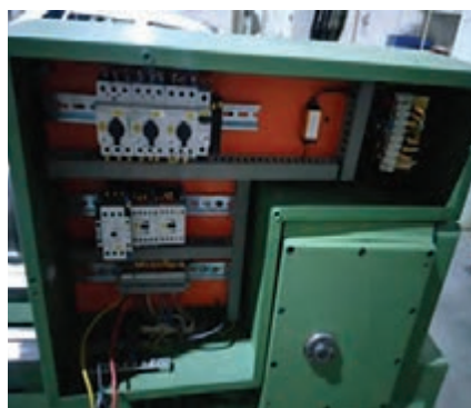
شکل ۷- جعبه تابلو برق دستگاه تراش
