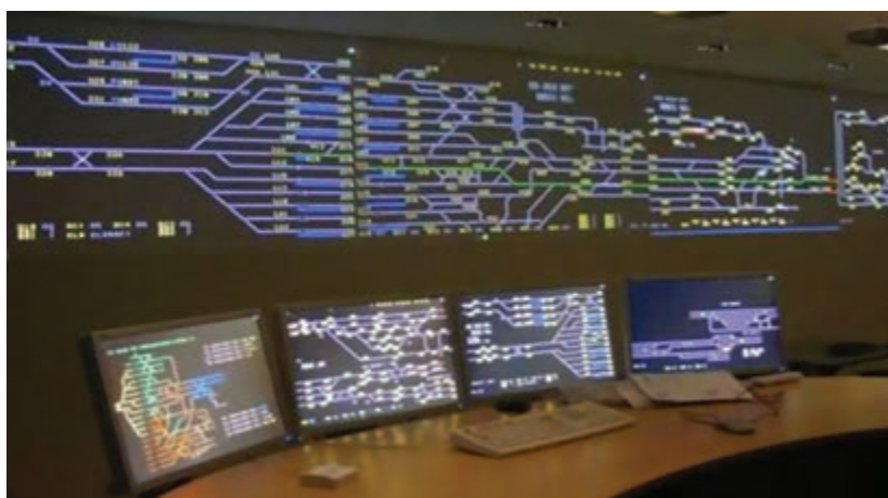
شکل ۴۱- نمایشگرهای میمیک پانل (ماشین – کاربر) در مرکز کنترل ترافیک
