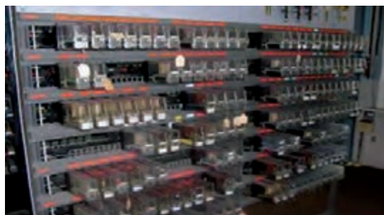
شکل ۳۳- نمونه‌ای از اینترلاکینگ مبتنی بر رله در مترو
