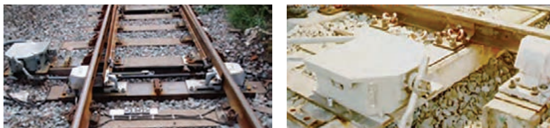
شکل ۳۲- نمایی از ماشین سوزن (تصویر راست) و متعلقات سوزن (تصویر چپ)
