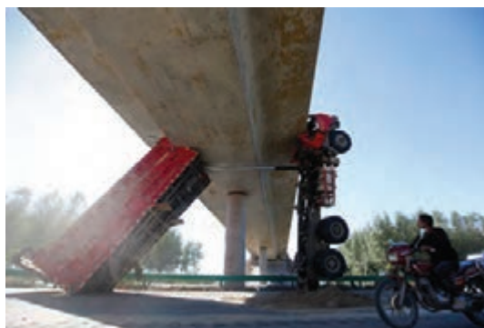
شکل ۶- نمونه‌هایی از برخورد کامیون با پل و تجهیزات
