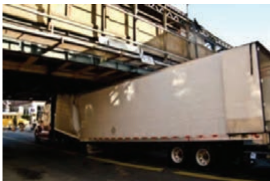
شکل ۶- نمونه‌هایی از برخورد کامیون با پل و تجهیزات
