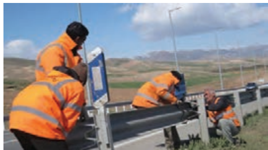
شکل ۷- نصب گاردریل کنار راه
