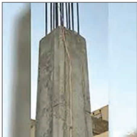
شکل ۲۲- اجرای هم‌بندی در ستون‌ها
