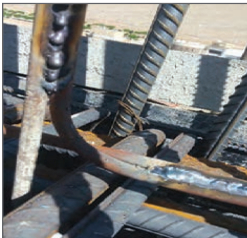
شکل ۲۱- جوشکاری هم‌بندی
