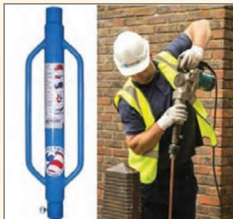
شکل ۲۶- کوبیدن الکتروود قائم در زمین
