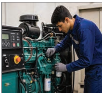
شکل ۲۷- سرویس و بازدید دوره‌ای دیزل ژنراتور
