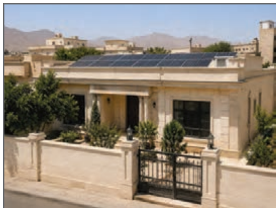
شکل ۳۲- کاربرد خانگی سیستم متصل به شبکه (پشت بام و پارکینگ مسقف خورشیدی)
