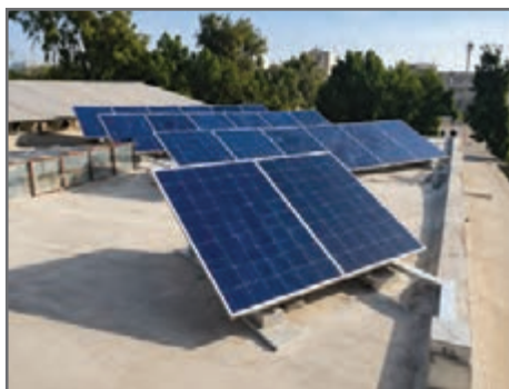
شکل ۳۳- سیستم‌های متصل به شبکه در پشت بام مدارس
