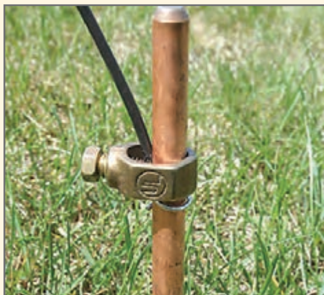
شکل ۲۶- کوبیدن الکتروود قائم در زمین
