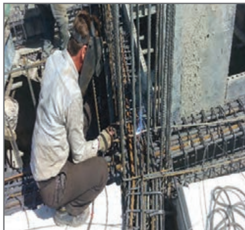
شکل ۲۱- جوشکاری هم‌بندی
