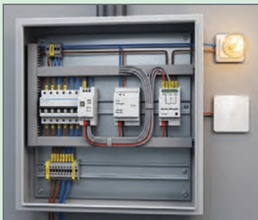
شکل ۱۰- اتصال تجهیزات کار عملی
