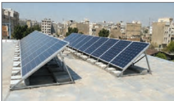
شکل ۳۳- سیستم‌های متصل به شبکه در پشت بام مدارس
