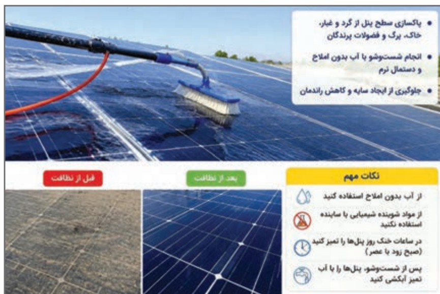
شکل ۴۲- نظافت پنل‌ها
