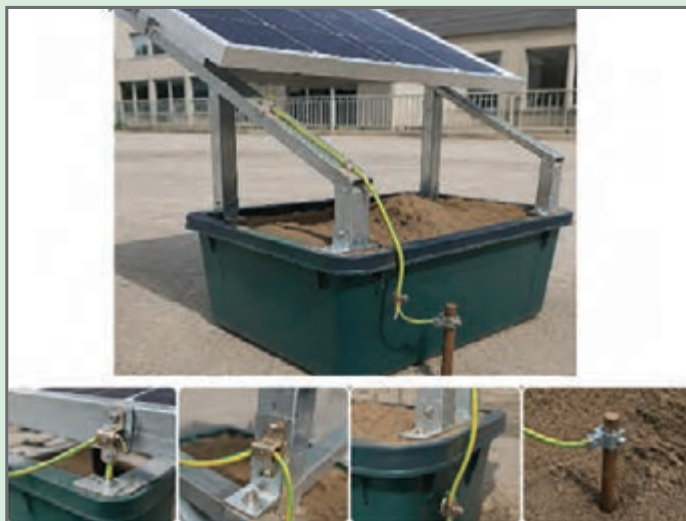
شکل ۲۹- اجرای همبندی و ارت بر روی سازه
