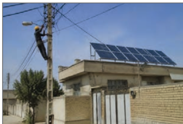
شکل ۳۶- تعمیرات متداول شبکه و لزوم قطع برق پنل توسط اینورتر
