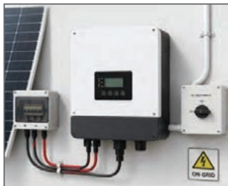
شکل ۳۳- اینورتر متصل از شبکه On-Grid
