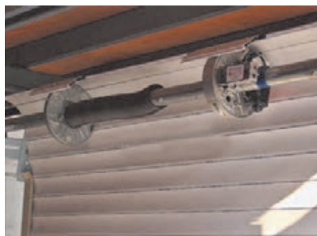
شکل ۲۶- محل نصب موتور کرکره‌ای
