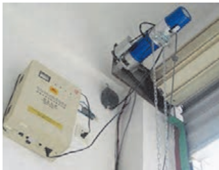
شکل ۳۰- یوپی‌اس مناسب برای در کرکره‌ای
