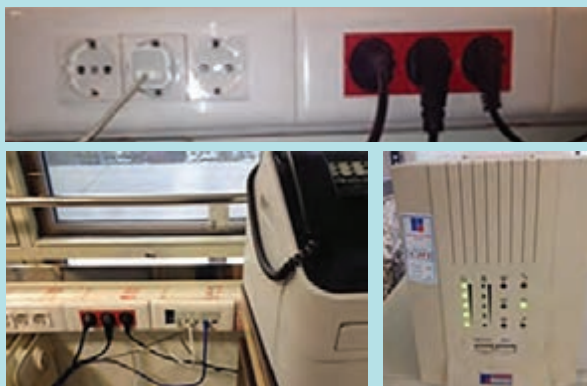
اتصال چند بار مختلف به UPS
