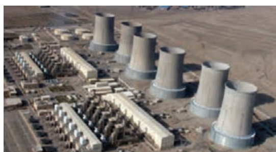
شکل ۲۵- نیروگاه سیکل ترکیبی دماوند
