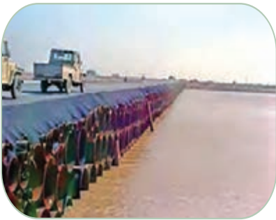
پل بعثت بر روی رودخانه اروندرود
