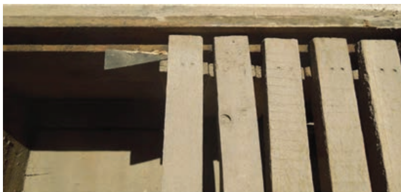
شکل ۵۱- استفاده از گوه برای محکم کردن قاب یا شان‌ها
