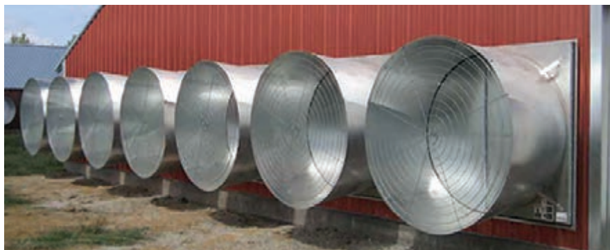
شکل ۲۴- استفاده از هواکش‌ها در تهویه
