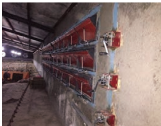
شکل ۴۶- ورود هوا از طریق پنجره‌های خودکار (اینلت)
