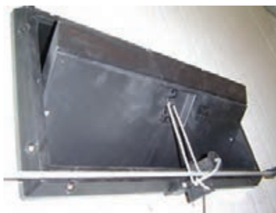
شکل ۳۶- دریچه‌های ورودی هوا (اینلت)
