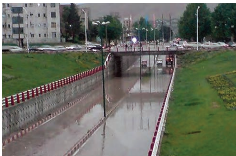
شکل ۱۰-۱۴- یکی از زیرگذرهای شهر خرم‌آباد
