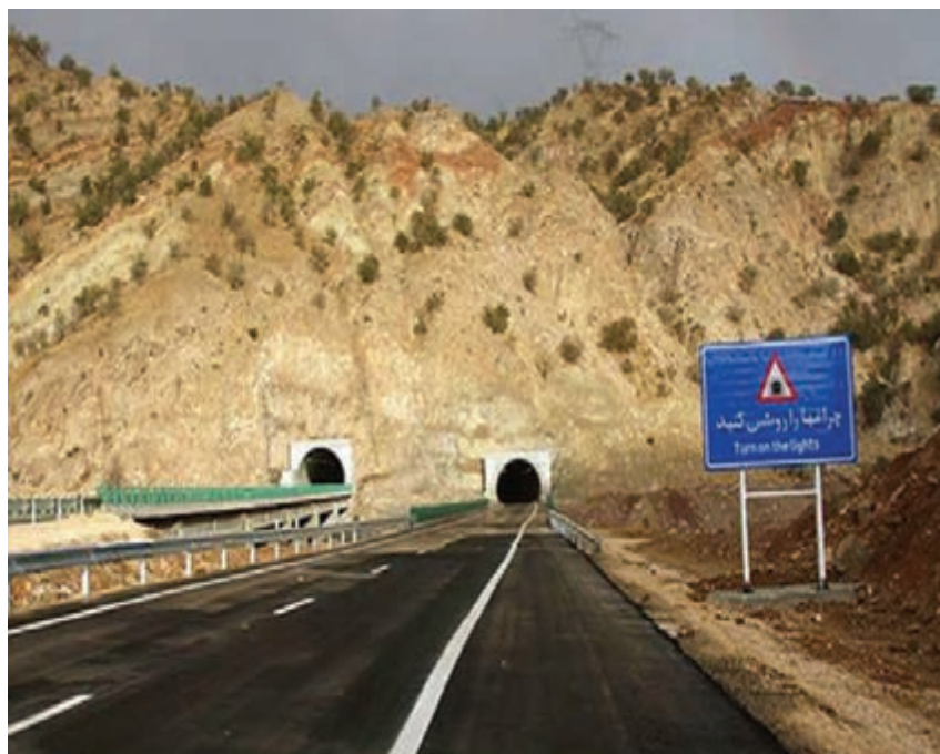
شکل ۱۲-۱۴ - آزادراه خرم‌آباد - پل زال
