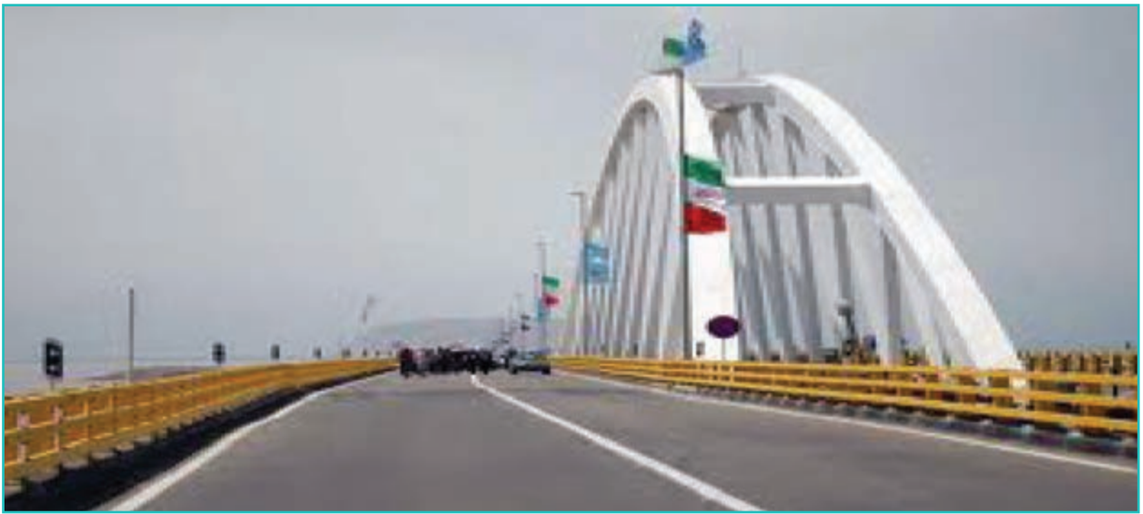
شکل ۶-۶ - پل میان گذر دریاچه ارومیه
