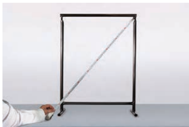
▲ شکل ۱۳ اندازه‌گیری قطرها
