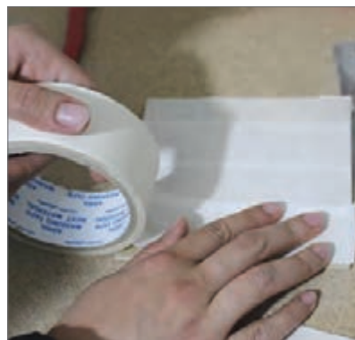
شکل ۲۶- پوشش سطح چوب با چسب کاغذی
