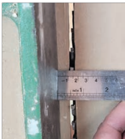
شکل ۳۱- تنظیم محل شیار لچکی
