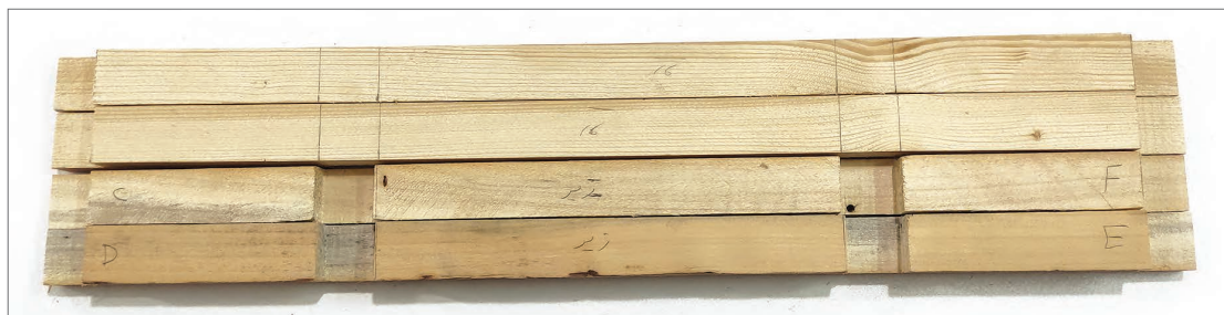
شکل ۶- اجرای اتصال نیم‌ونیم در کلاف‌های فرعی
