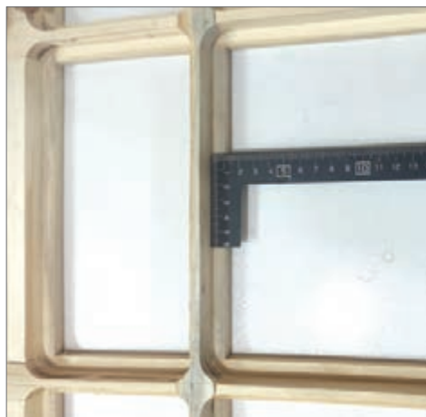
شکل ۱۶- اندازه‌گیری ابعاد داخلی قاب‌ها و عمق دوراهه
