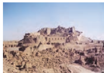
الف) ارگ بم بعد از زلزله
