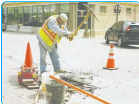
استفاده از کلنگ در کندن زمین
