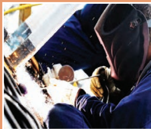
اجرای خط جوش
