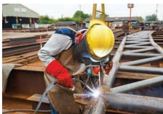
جوشکاری سازه فولادی
