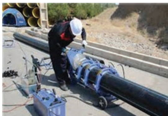
جوشکاری لوله‌های پلی اتیلن
