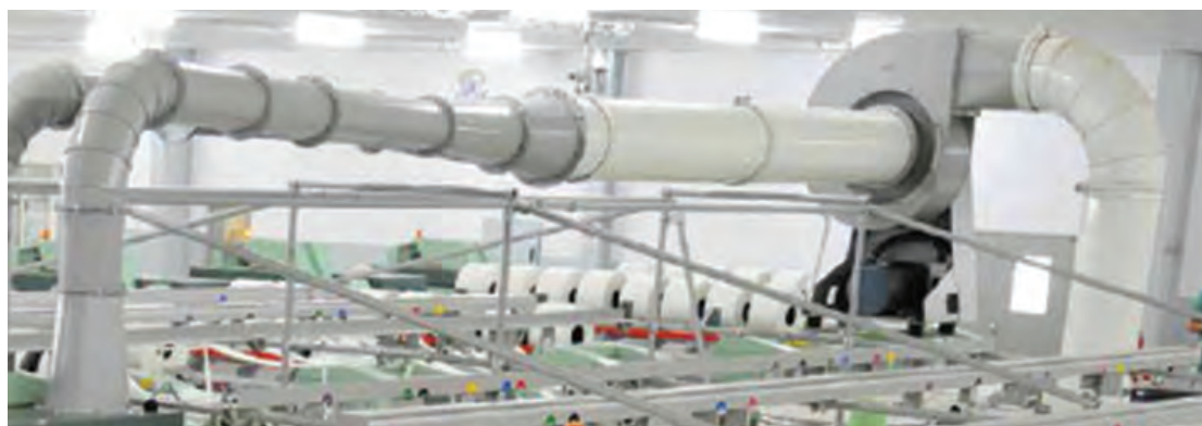
شکل ۲۵- تقویت فشار انتقال الیاف
