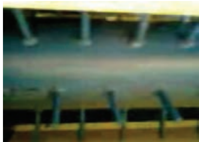
شکل ۹- زنده جوشکاری شده
