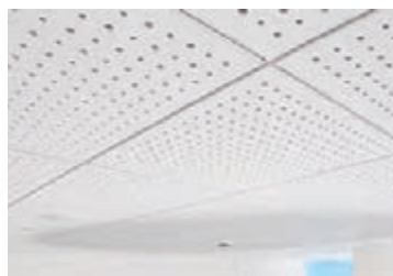
شکل ۹۲- سقف کاذب آکوستیک
