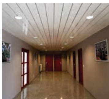
شکل ۸۸- سقف کاذب پی وی سی
