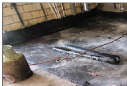
شکل ۴۵- عایق کاری کف آشپزخانه بعد از کف سازی
