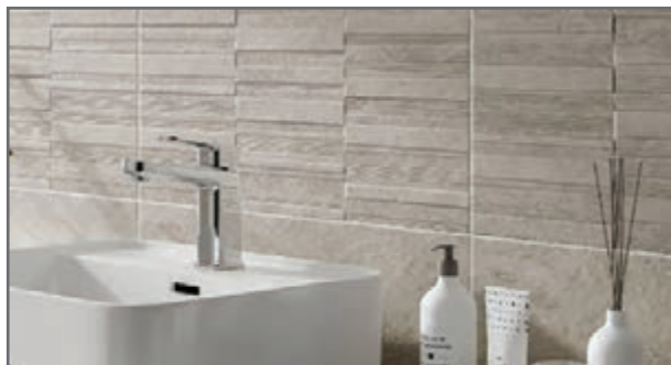
شکل ۴۱- چیدمان سه بعدی در دیوار
