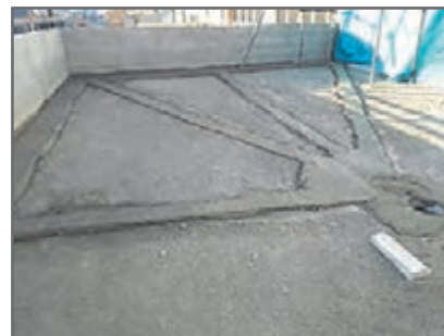
شکل ۷۷- کرم‌بندی و شمشه‌گیری بین آنها
