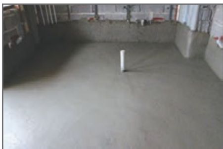
شکل ۴۶- کف سازی آشپزخانه و پلاستر جهت دیوار عایق کاری
