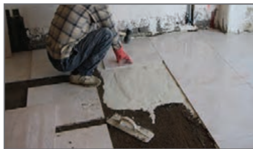
شکل ۴۸- اجرای سرامیک کف به روش شیره چسبان
