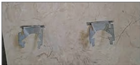
شکل ۹۰ - اجرای اسکوپ پشت سنگ پلاک
