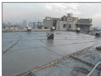
شکل ۷۸- پر کردن فاصله بین شمشه‌های سیمانی با بتن سبک
