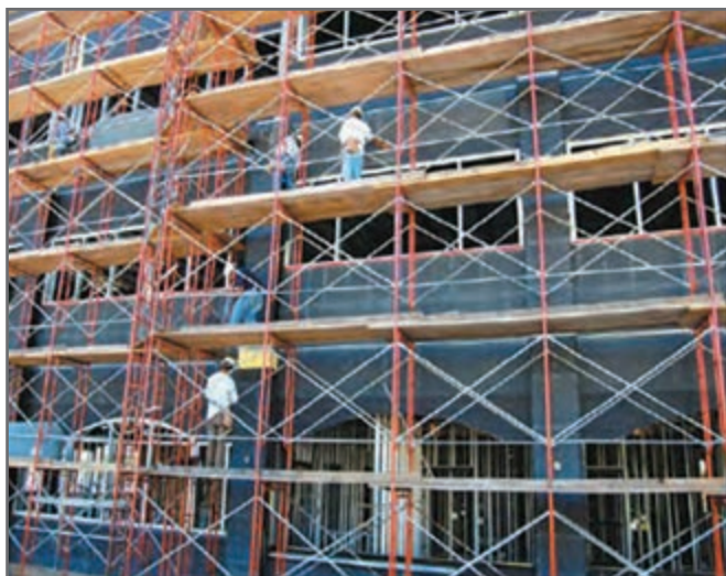
شکل ۲۰- نمای یک ساختمان ۵ طبقه پوشانده شده با استفاده از داربست به منظور اجرای نمای سیمانی
