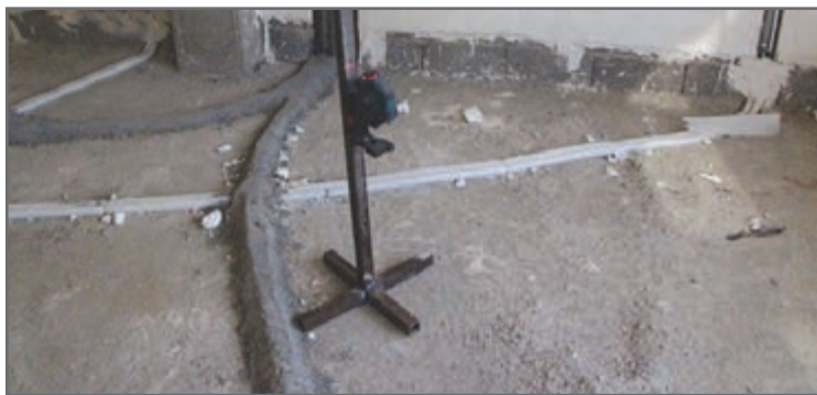
شکل ۴۴- اجرای ماهیچه بتنی روی لوله‌های تأسیسات
