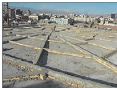
شکل ۷۷- کرم‌بندی و شمشه‌گیری بین آنها
