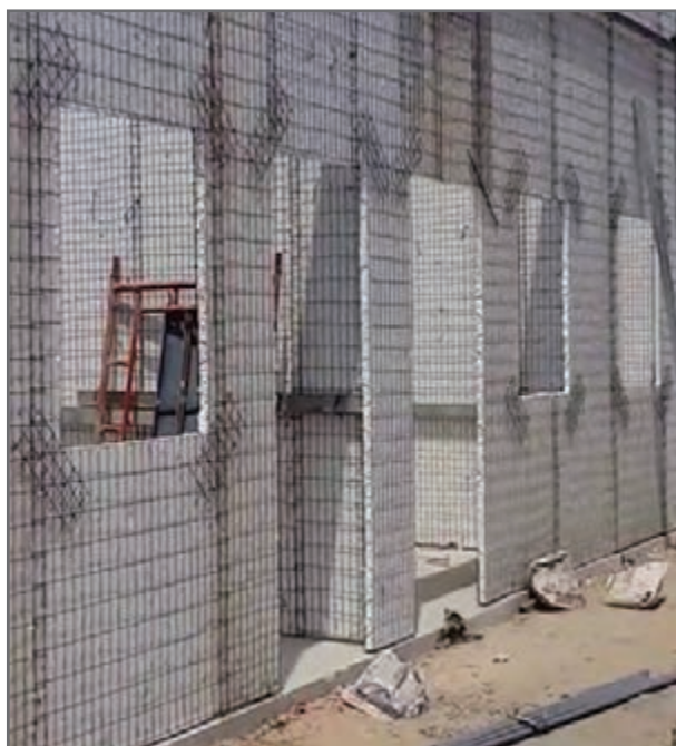
شکل ۳۶- تقویت بازشوی دیوار تری‌دی‌پنل
