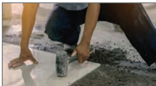
شکل ۴۷- اجرای سرامیک کف به روش سنتی
