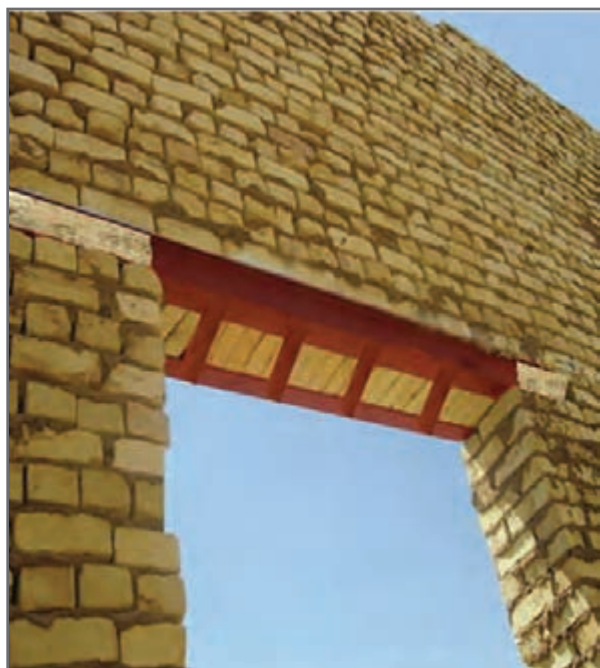
شکل ۳۵- گشودگی دیوار آجری به کمک نعل درگاه
