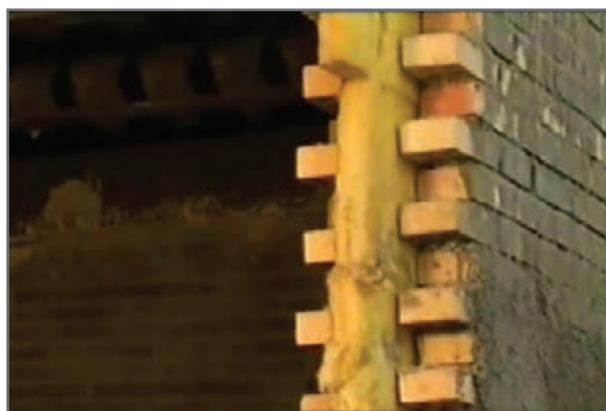
شکل ۷۱- نصب عایق بین دو دیوار
