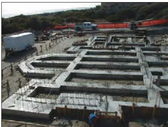
شکل ۳-۶۲ پی بتن مسلح نواری شبکه ای زیرستون
