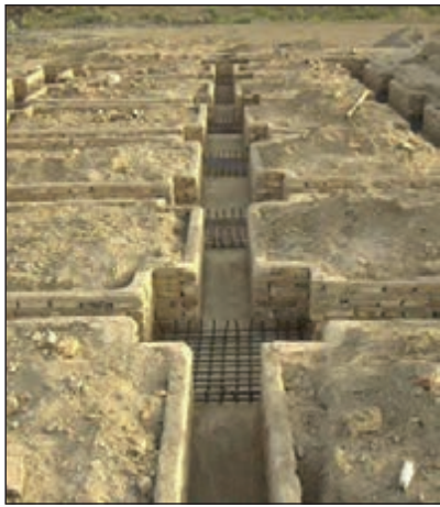
شکل ۳-۵۴ آرماتورگذاری پی تکی کلاف بندی شده
