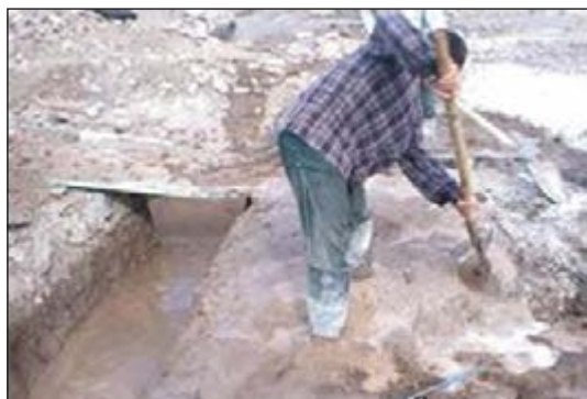
شکل ۳-۳۷ اجرای شفته آهک در فونداسیون
