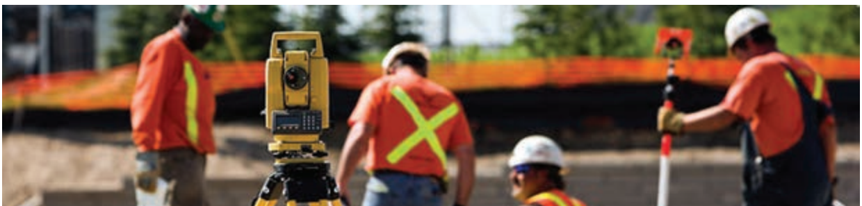
شکل ۴-۱. پیاده کردن با دوربین نقشه برداری
