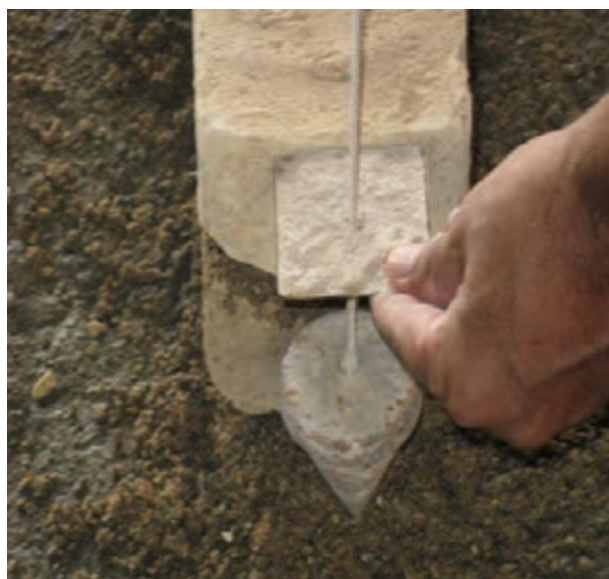
شکل ۱ - ۹۴: شاقول کردن نبش کار
