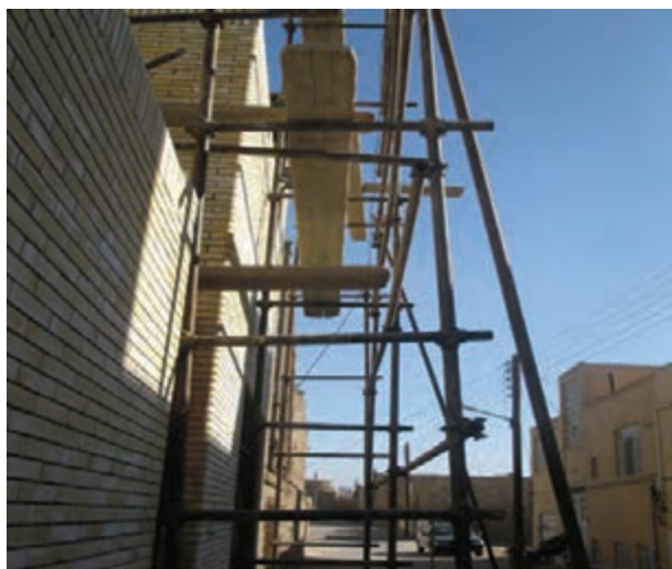
شکل ۱-۱: داربست فلزی برای چیدن دیوار
