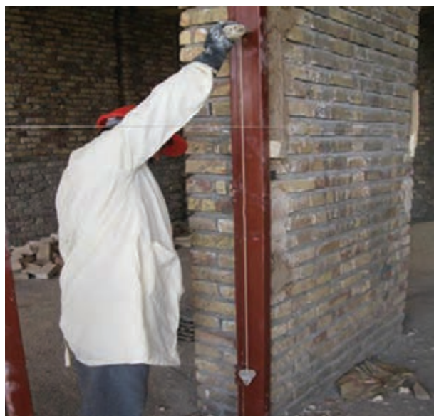
شکل ۳-۲۳: شاقول کردن وادار
