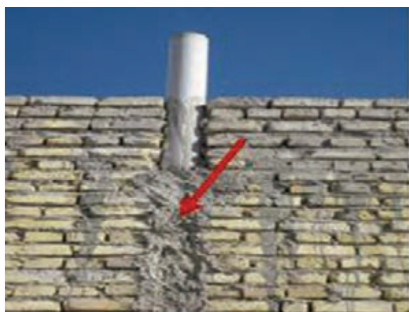
شکل ۱- ۶۵: پر کردن درز لوله‌ها
