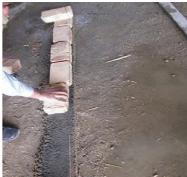
شکل ۱ - ۹۱: نحوه چیدن آجر در امتداد ریسمان کار
