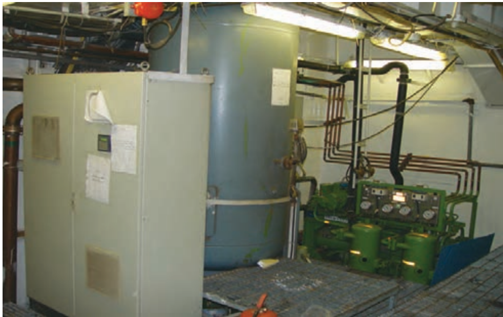
شکل ۱۷- سامانه هوای فشرده
