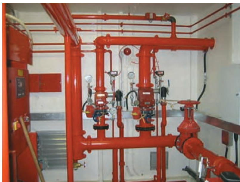
شکل ۱۰- قسمتی از سامانه آتش‌نشانی یک شناور
