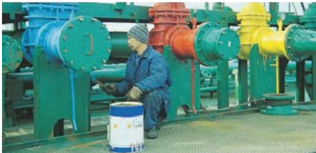
شکل ۵۵- رنگ آمیزی سامانه‌های لوله‌کشی بر روی عرشه
