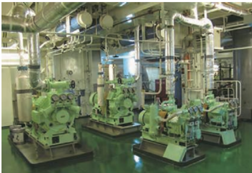
شکل ۱۹- کمپرسورهای هوا در ساختمان کشتی
