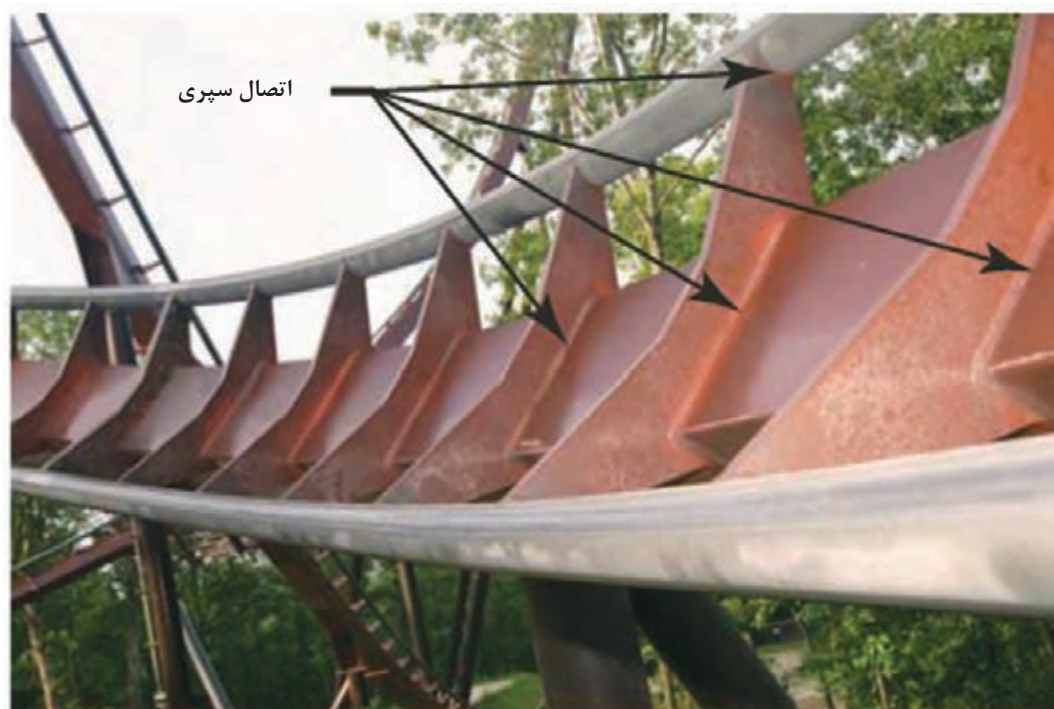
شکل ۱۲- کاربرد اتصال سپری
