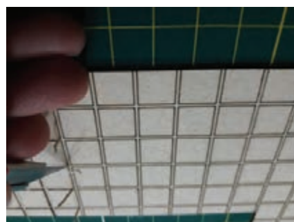
شکل ۹۲-۵- ایجاد شیار روی سقف
