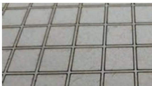
شکل‌های ۵-۹۸ و ۵-۹۹- ساخت حیاط و کف با استفاده از برداشتن لایه‌ای از روی مقوا و ایجاد طرح موزاییک و سنگ فرش.
