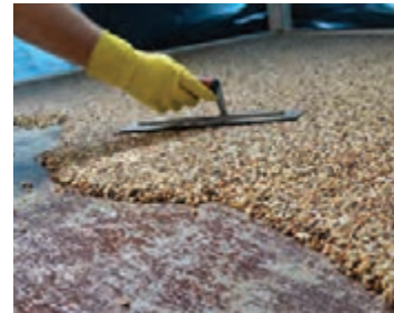
شکل ۳-۴۳- نمایش نحوه پخش و اجرای اپوکسی گرانیته
