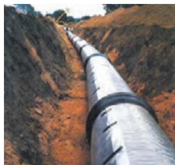
▲ شکل ۲-۲۲ لوله کشی انتقال آب شهری
