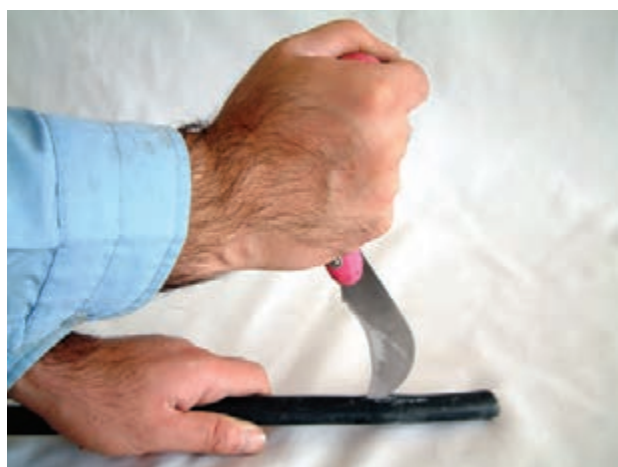
شکل ۵-۳۲ روکش برداری غلط
