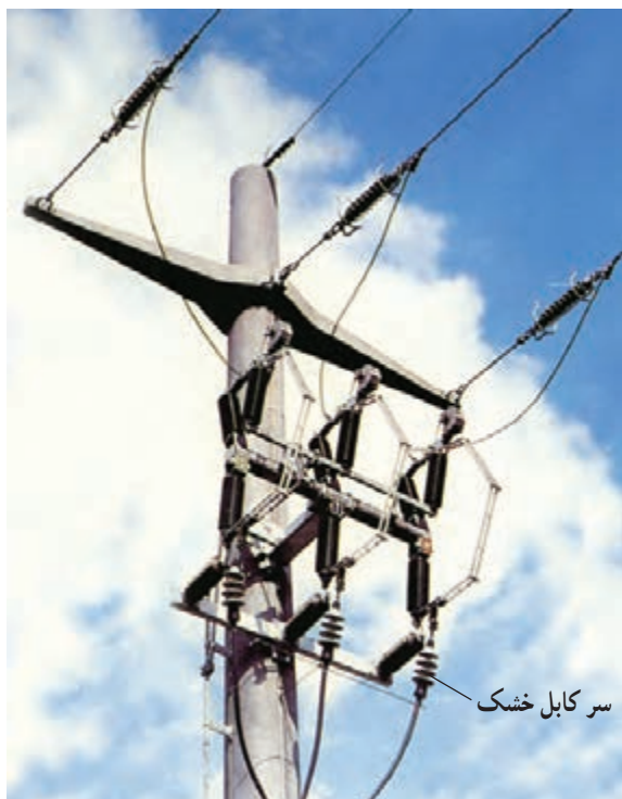
شکل ۶-۶- سر کابل خشک حرارتی هوایی
