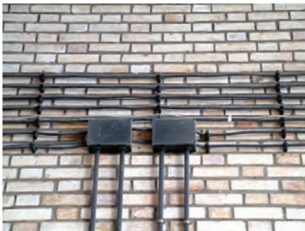
شکل ۵-۵۷- کابل‌کشی روی دیوار
